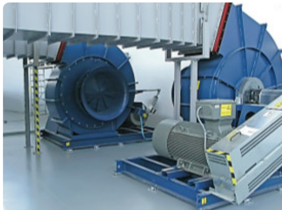
Le balourd est critique dans les installations à ventilateurs (transmission directe ou poulie courroie)
