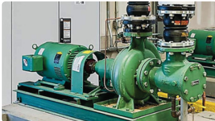
Le désalignement est critique dans les installations à machines accouplées (transmission directe)
